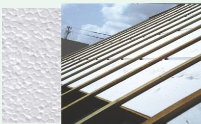
**Außendämmung von Dach und Decke, vor Bewitterung geschützt, Dämmung unter Deckungen**
